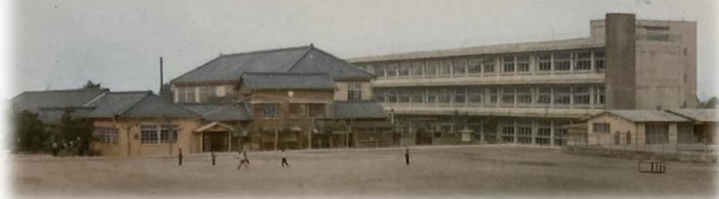
木造校舎と昭和33年完成の鉄筋3階建校舎の様子
